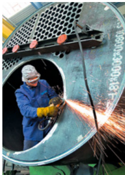
Schweißen des Gasboilers | Bild: Bosch
