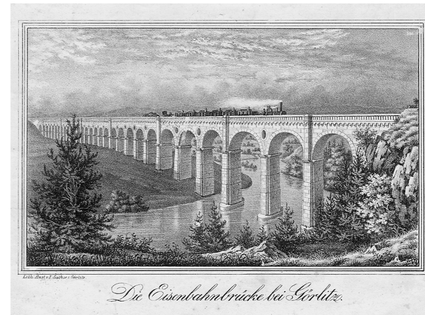
Das 1847 fertiggestellte Neisse-Viadukt war eine der größten Eisenbahnbrücken Schlesiens.
