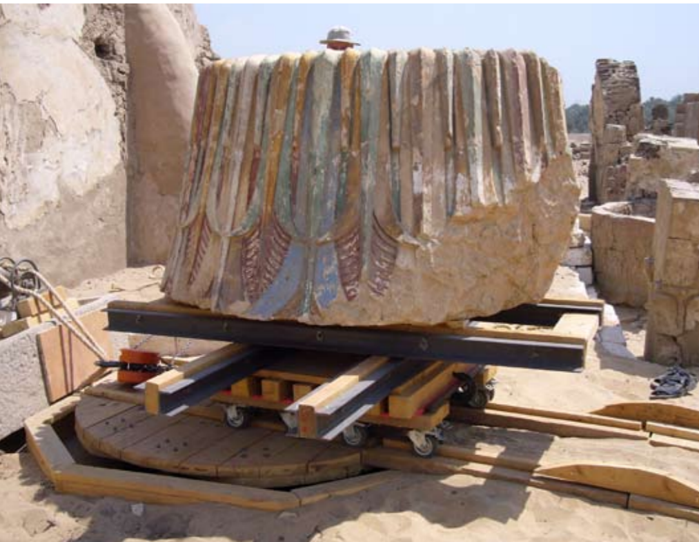
Ein mehrfarbiges Kapitelfragment lagert auf einer extra gefertigten Drehscheibe, die beim Transport Richtungswechsel erlaubt.
