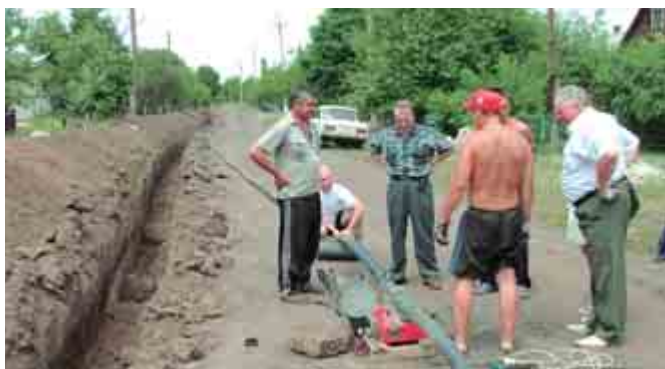
Bau einer Wasserleitung im Gebiet Donezk, Ukraine. Строительство водопровода в Донецкой области (Украина).
