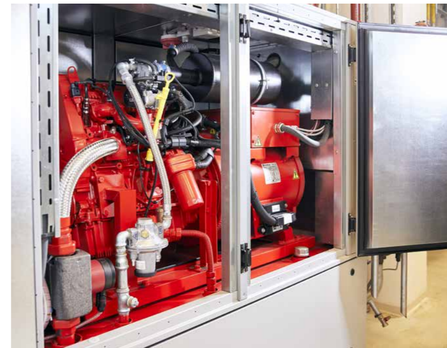
Blockheizkraftwerk zur Kraft-Wärme-Kopplung, ein integraler Teil von Energiesystemen.
