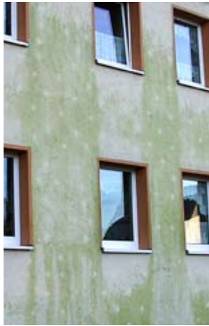
Veralgte Fassade eines Mehrfamilienhauses. Die nachträgliche Wärmedämmung hat die ungewollte Begrünung begünstigt. Ist ausreichend Wasser vorhanden, wird aus einem anfänglich zaghaften Bewuchs mit Mikroalgen schnell eine „grüne Haut“, wie auf der steinernen Statue unten.
