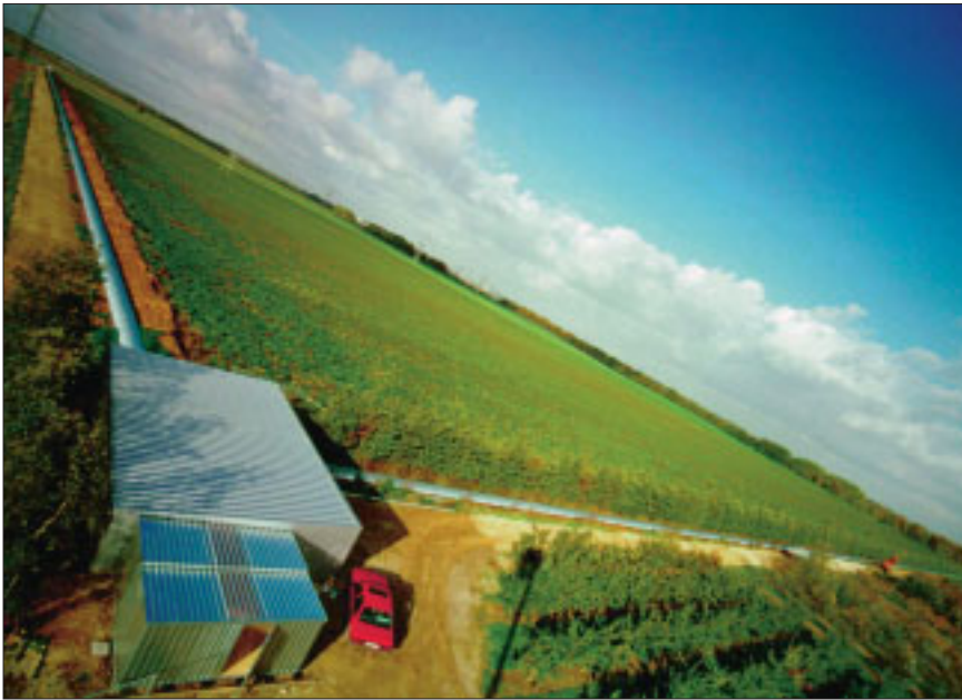
GEO600 aus der Vogelperspektive: Vom kastenförmigen Hauptgebäude des Gravitationswellendetektors gehen zwei jeweils 600 Meter lange Messstrecken ab, die durch Endhäuser abgeschlossen werden. Die Messstrecken selbst (rechts) verlaufen in Edelstahlrohren, die in einem Graben aufgehängt sind.
