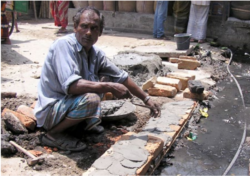
Eine Drainage wird mit den verfügbaren Baustoffen improvisiert.
